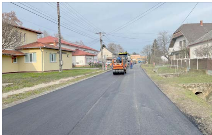
Az elmúlt időszakban több fontos útfelújítás történt.
