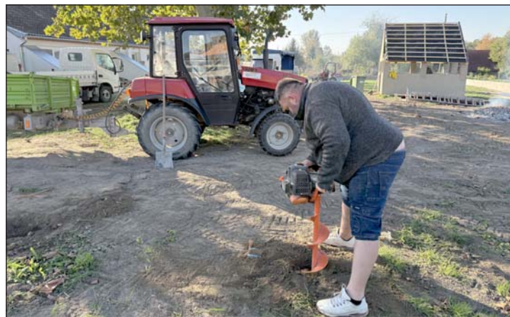
Betonozzák az új bölcsi kerítésének az alapját.
