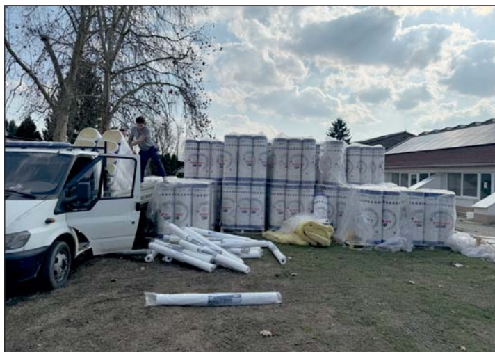
40 épület vár még a tető szigetelésére.
